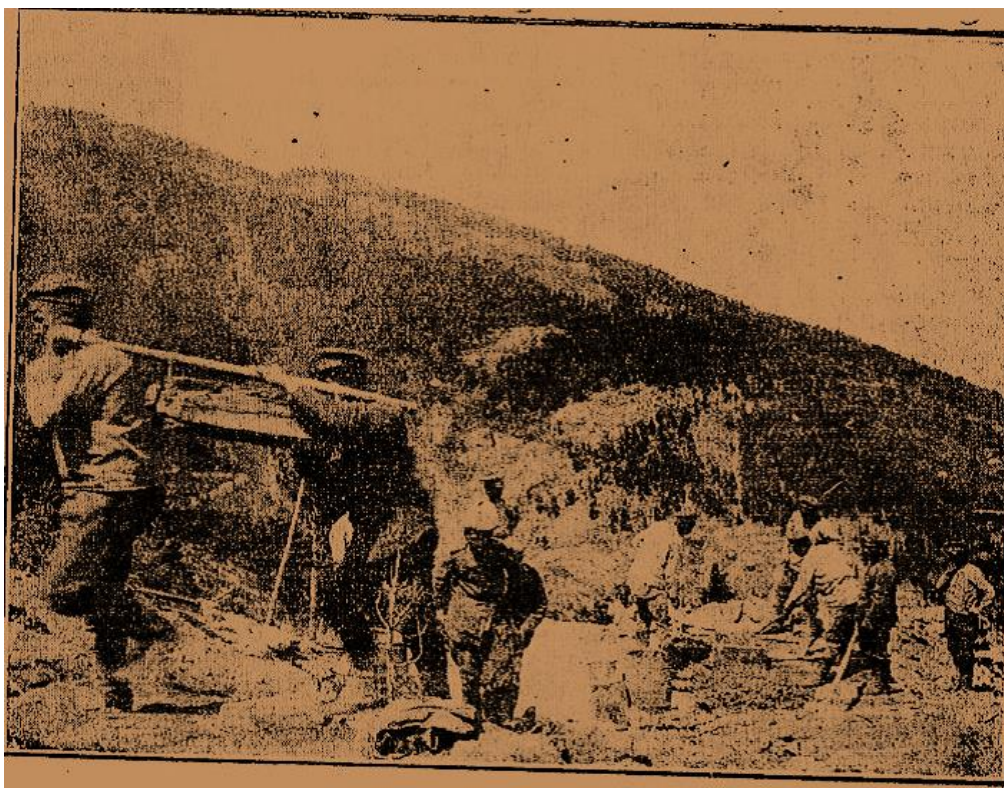
Приготоввяване на бетон на позицията
