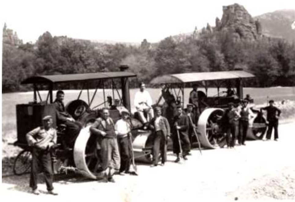
Строителството на новото шосе, 1939 г. 9)
