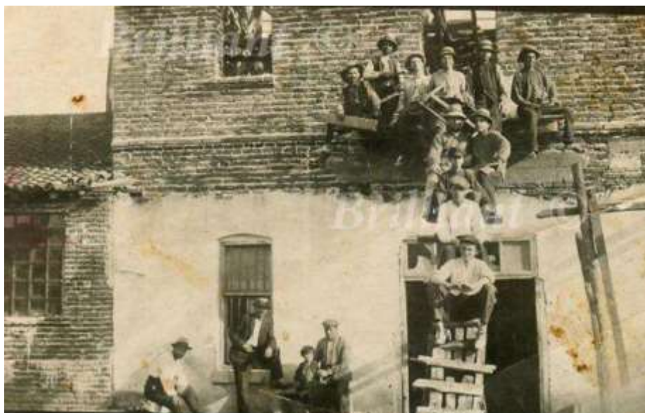
1926 г. Средец, обл. Бургас, строителството на мелницата на Начо Желязков – 2 етаж
